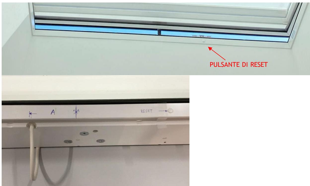
Lunghezza del cavo 4m. Il cavo deve essere collegato al sistema di controllo KUX 110 in dotazione.
