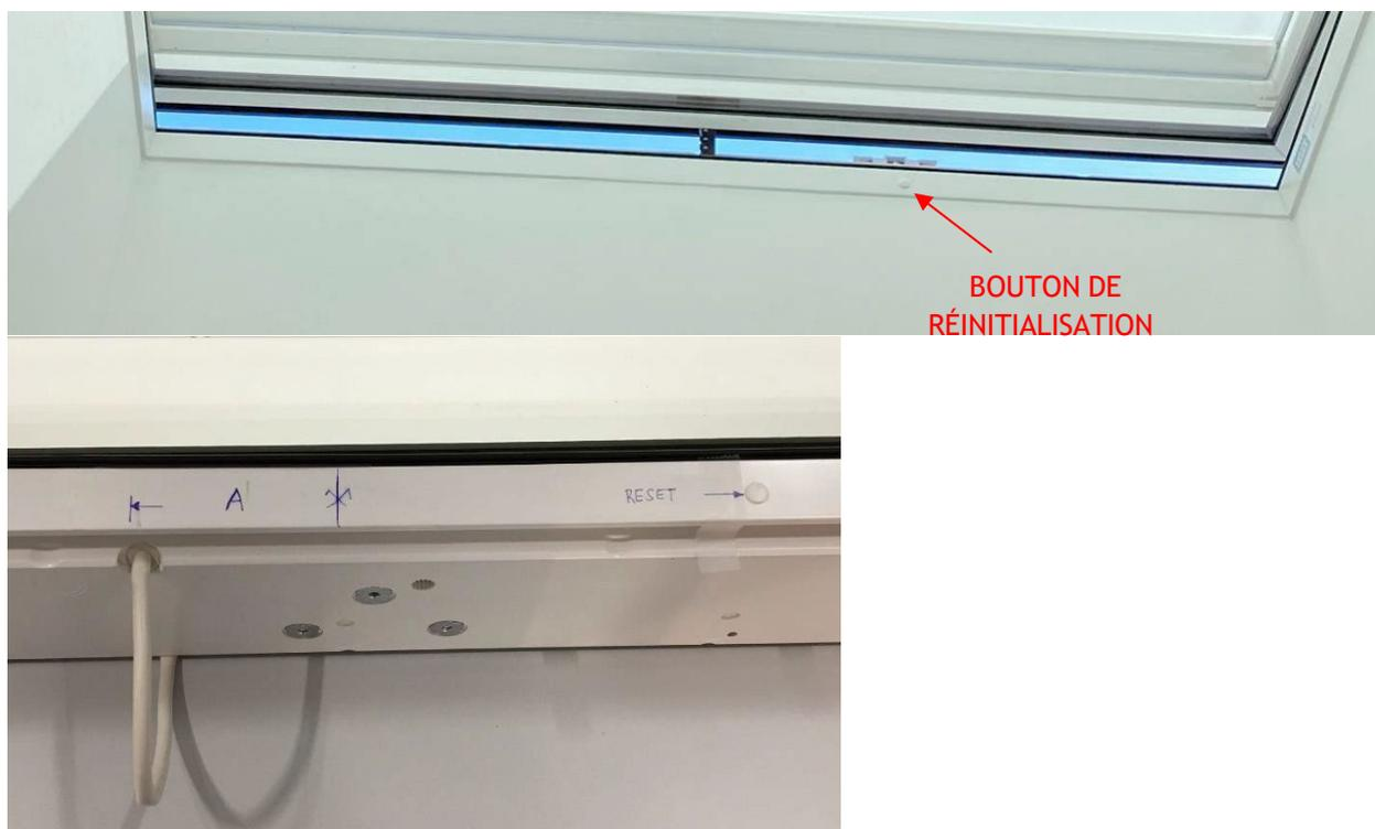
Longueur du câble 4m. Le câble doit être raccordé au système de commande KUX 110 fourni.
